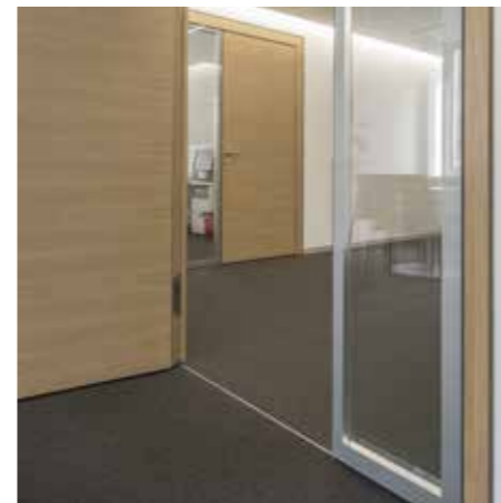
B | Panneau latéral en verre composite (GVS), affleurant des deux côtés avec portes en bois, sans profilé de montant Ouvrage | Caisse d'épargne, Nuremberg, Allemagne Photos | R. Kuhn, Küffner
