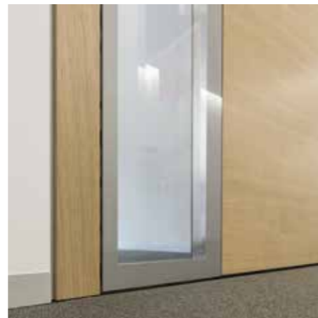
B | Panneau latéral en verre composite (GVS), affleurant des deux côtés avec portes en bois, sans profilé de montant Ouvrage | Caisse d'épargne, Nuremberg, Allemagne Photos | R. Kuhn, Küffner
